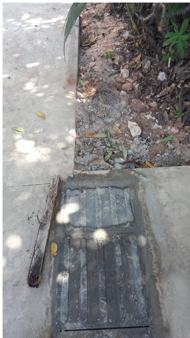
Foto 7 - Piso tátil mal posicionado.
