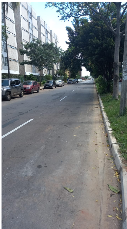
Foto 4 - Pintura antiga se fundida com nova pintura causado confusão para o motorista.
